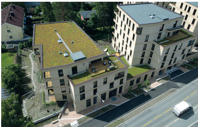
Deler av taket har sedumdekke.
